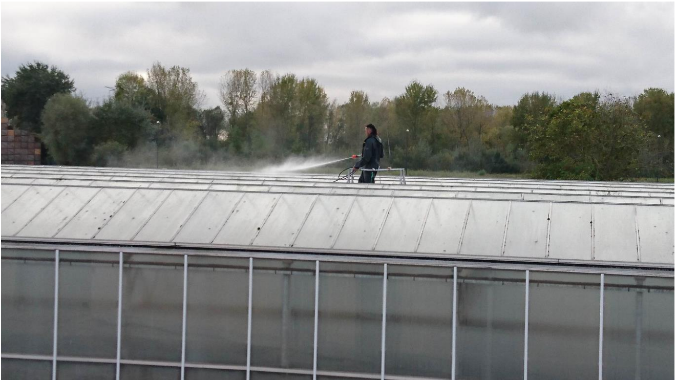
Figure : Nettoyage et démoussage de la toiture des serres
